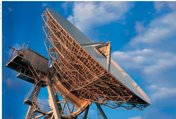
30-Meter-Antenne für Deep-Space-Missionen in Weilheim
